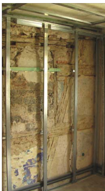
Fachwerkwand mit der vorbereiteten Unterkonstruktion für die Beplankung
