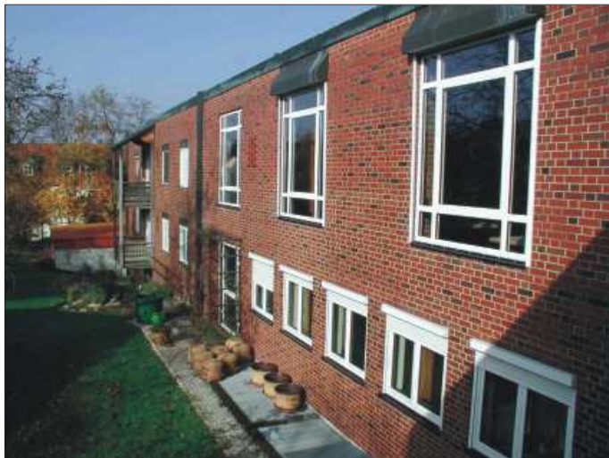
Typisches Gebäude aus den 60er Jahren mit Kaltdach
