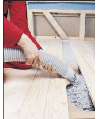
Einfach einblasen in die Zwischendecke
